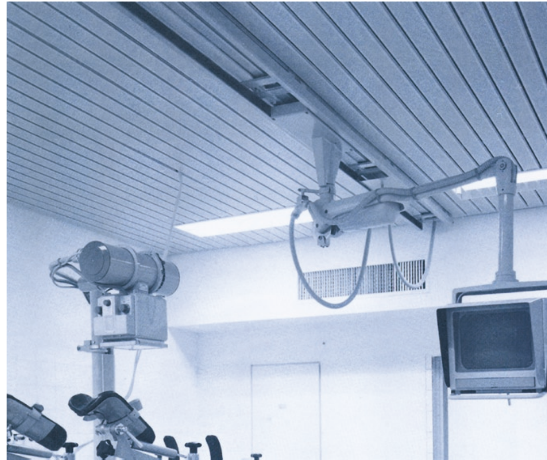
Paneeldecke im Operationssaal
